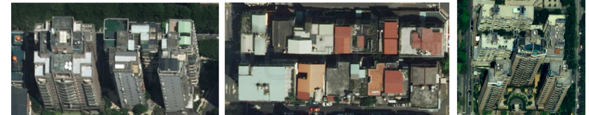
▲正射影像建物傾斜狀況
